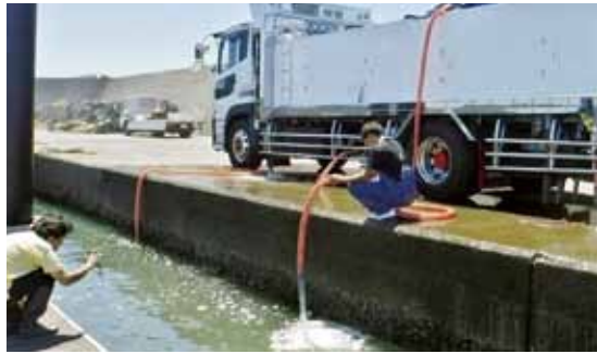
岸壁からの放流試験
