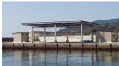
完成した畜養魚の荷捌き施設
