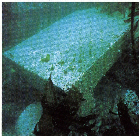
写真14 N型礁 コンクリート板の両端がL型になっていて、成長したアワビのすみ場・漁獲場として良い
