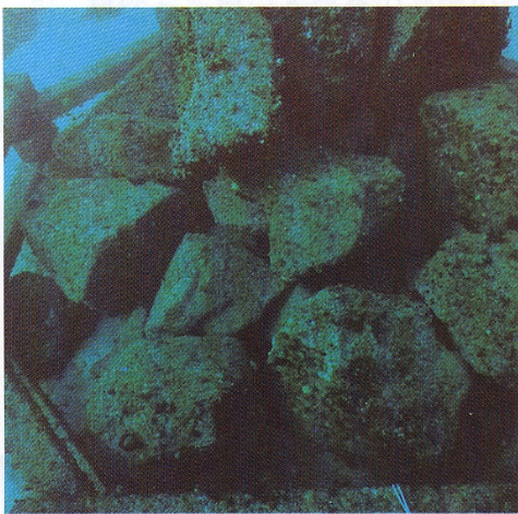
写真10 井桁礁 コンクリート柱を八角に組み、 その中に200~300kgの安山岩 を入れたもの
